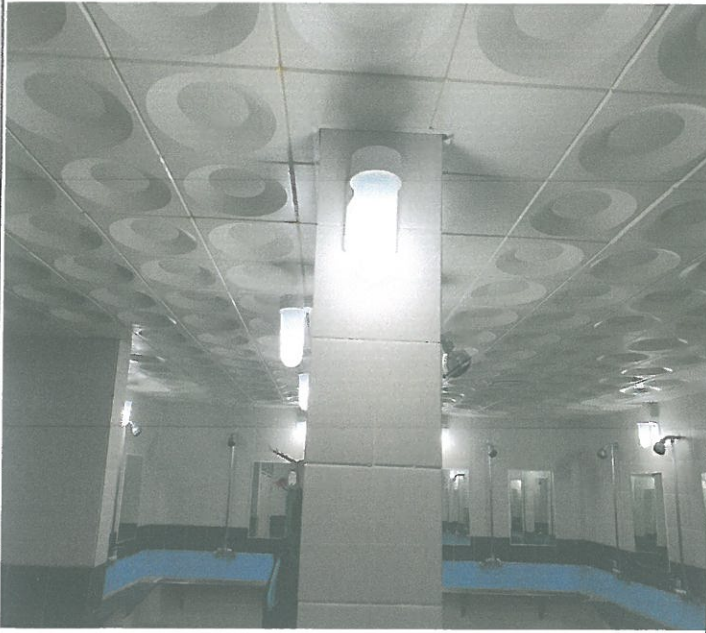
수영장 남자 샤워실 전등 교체
