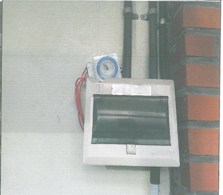
체육관 외벽 전등 타이머 설치
