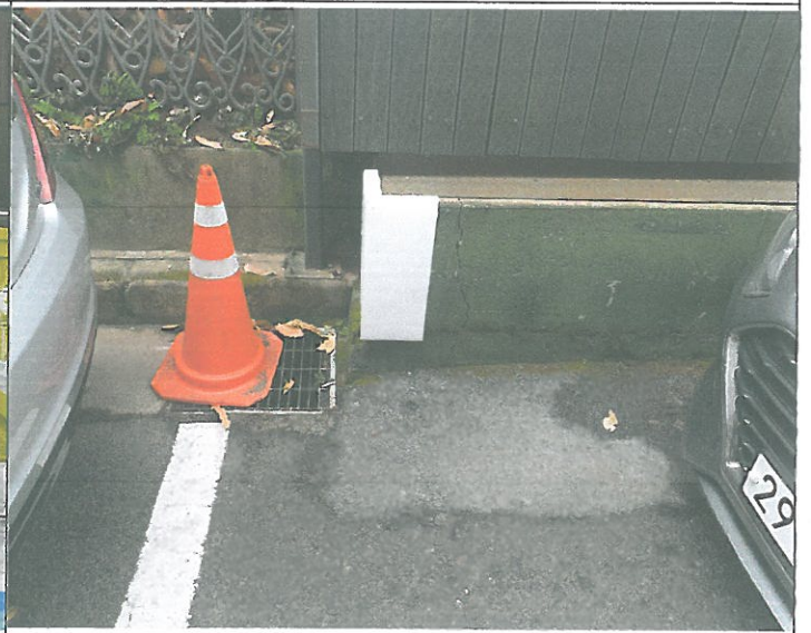
건물 후면 주차장 우수 침점멘홀 벽각 차량접촉 리브설치
