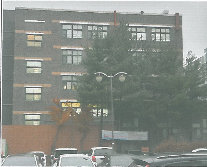
주차장 가로등 전등 교체
