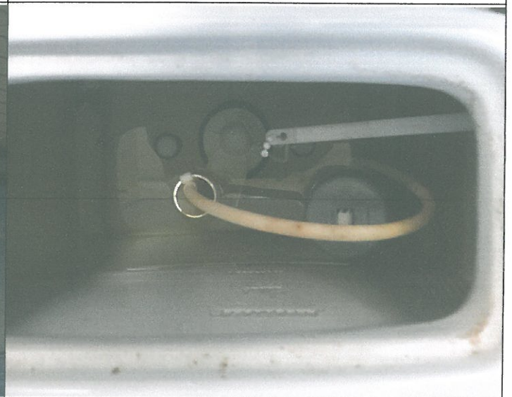
수영장 여자 샤워실 변기 샤펴 파손 교체
