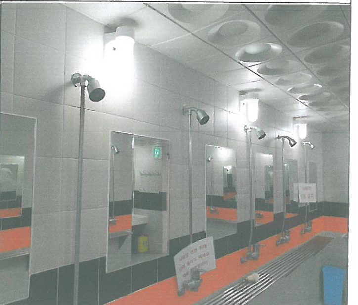
수영장 남자 1개소 여자 3개소 샤워장 벽 등 전구 교체
