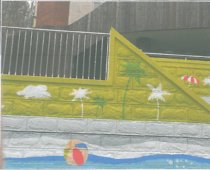
수영장 앞 도로변 벽면 안내판 철거 도색
