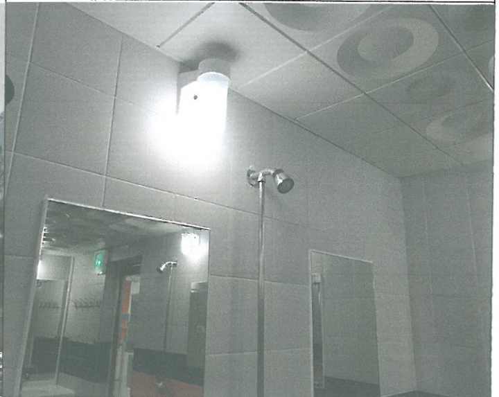
수영장 여자 샤워실 내부 샤워기 노즐 2기 교체
