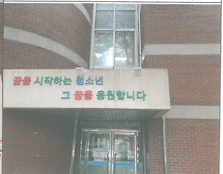
1층 방과후 복도 출입구 방풍실 외벽 등 설치
