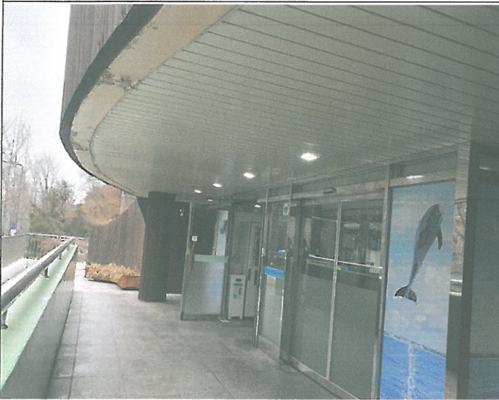
수영장 입구 및 방풍실 천장 매립등 점등 불량 복구
