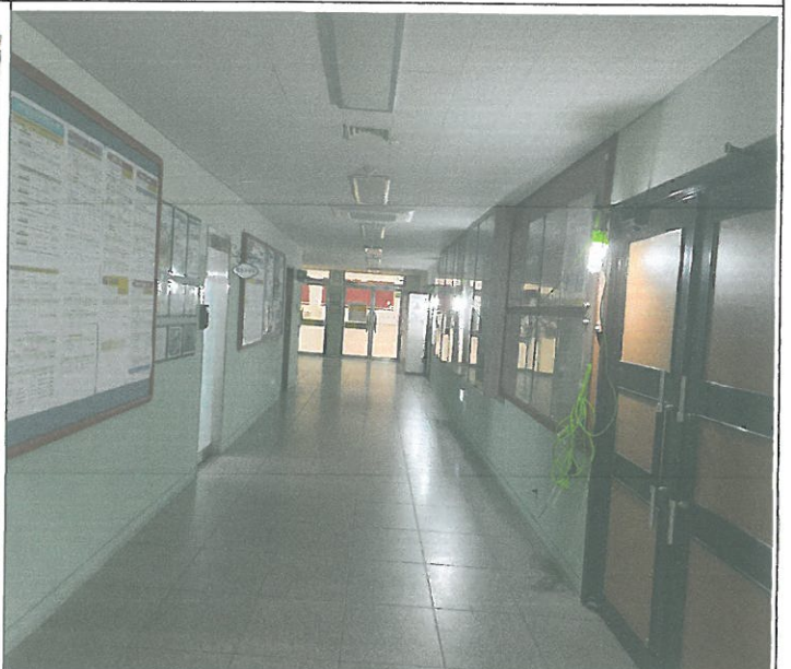
1층 평생 교육팀 복도 천장 매립 등 누전 임시 조치
